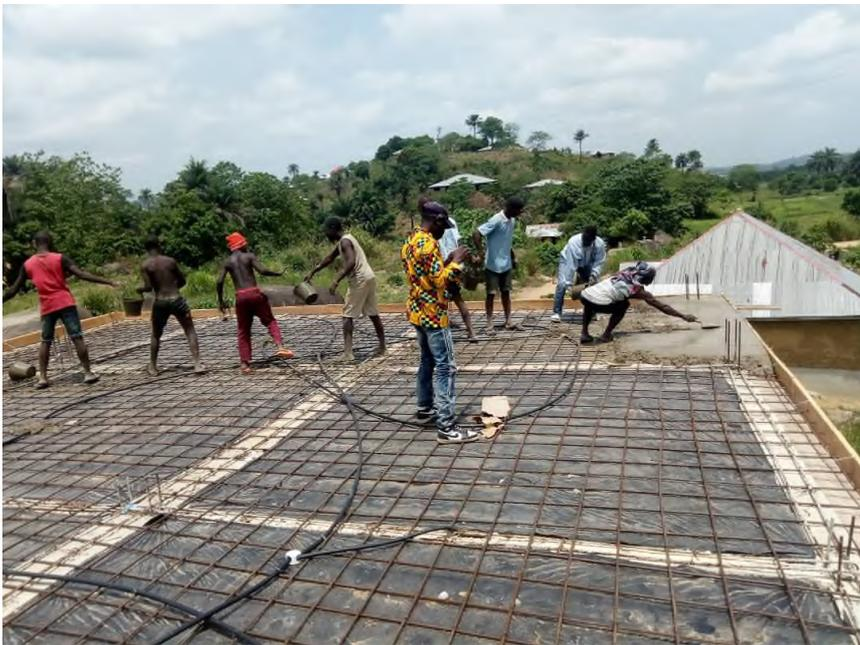
Mit einer Eimer-Kette wird das Betongemisch langsam und mühsam verteilt.
